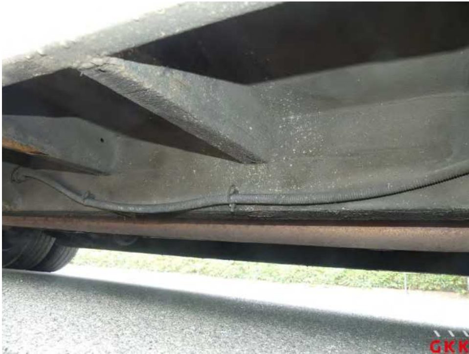
Bild 53 Fahrzeug, Rahmen, korrodiert, instand setzen - lackieren
