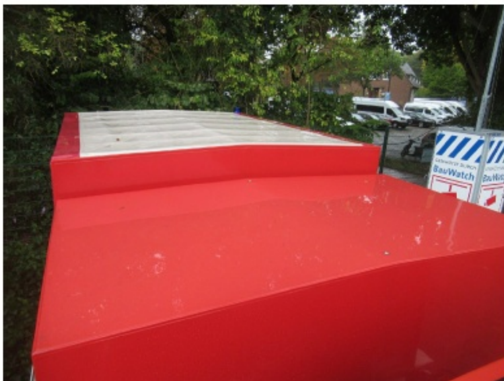
Bild 6 : Übersicht Dach Aufbau
