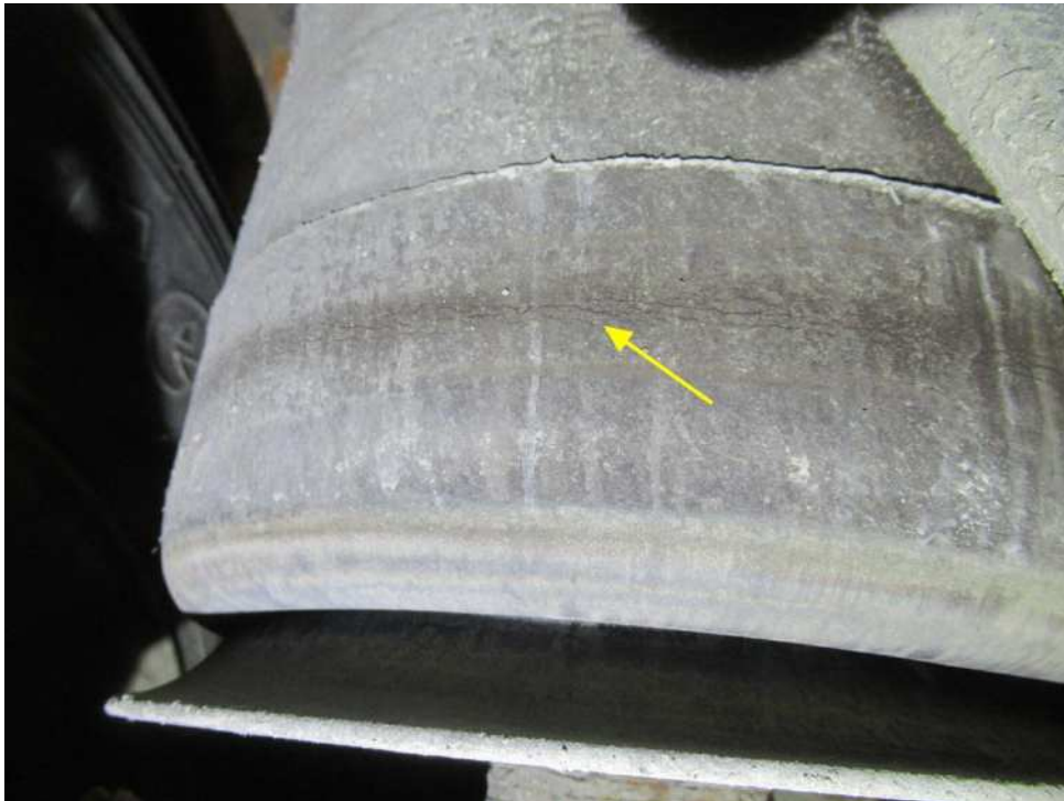
Bild 18 : Luftbälge hinten rissig
