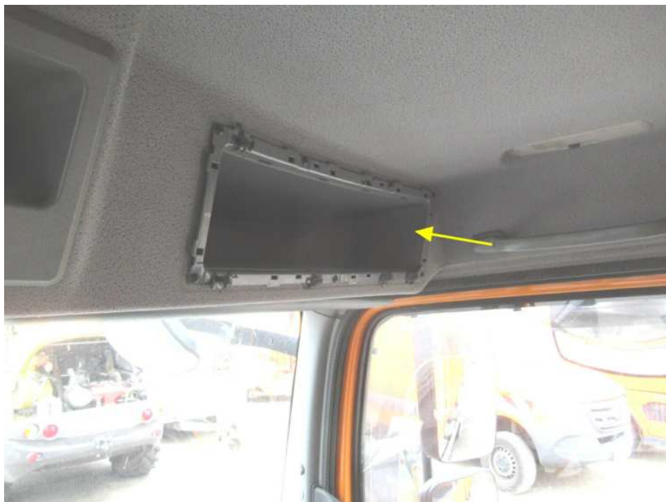
Bild 10 : Klappe Dachablage rechts fehlt
