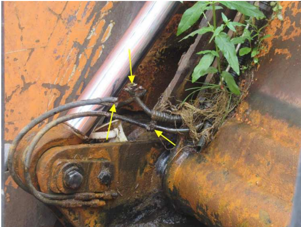
Bild 11 : Zentralschieranlage teilweise durchtrennt, prüfen und
