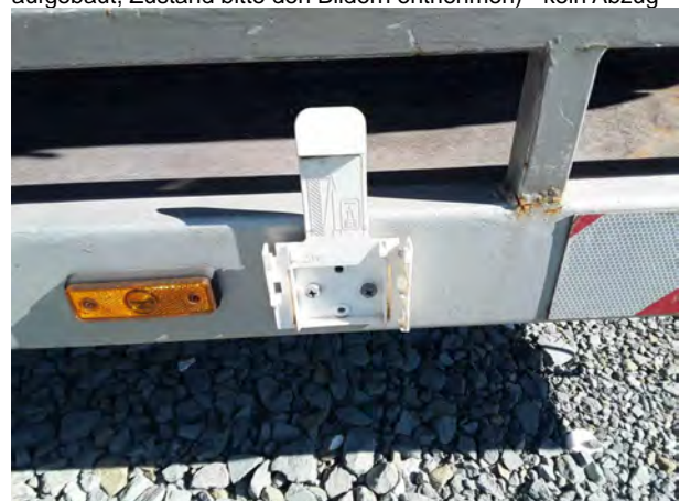
Beschädigung 2: Sonstiges: Sonstiges (Unterlegkeil) - fehlt - erneuern
