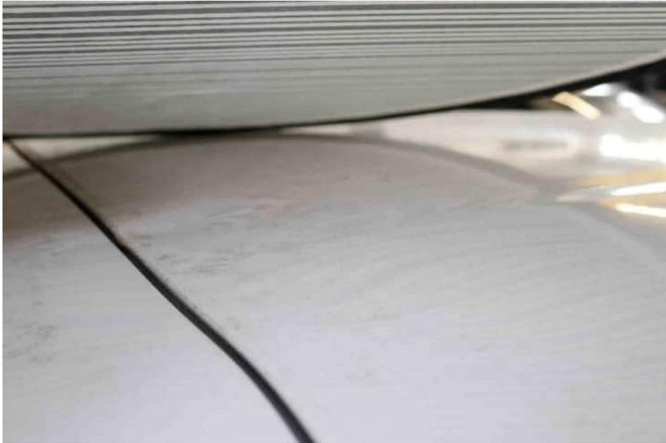
Bild 21 Detailaufnahme deformiertes Dach
