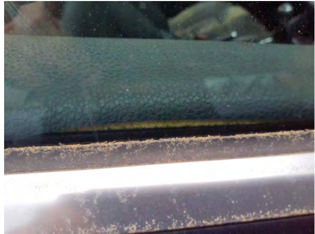
Beschädigung 18: Verkleidungen/Abdeckungen: Türverkleidung vorn rechts - lose - erneuern
