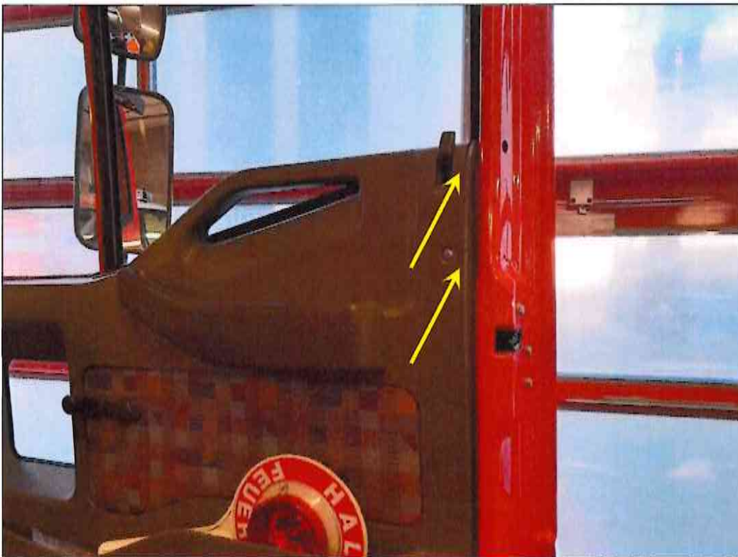
Bild 24 Türverkleidung rechts gebrochen
