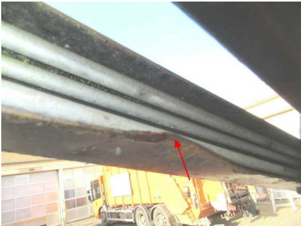
Bild 22 : Schutzblech Hydraulikleitungen Kranausleger verformt
