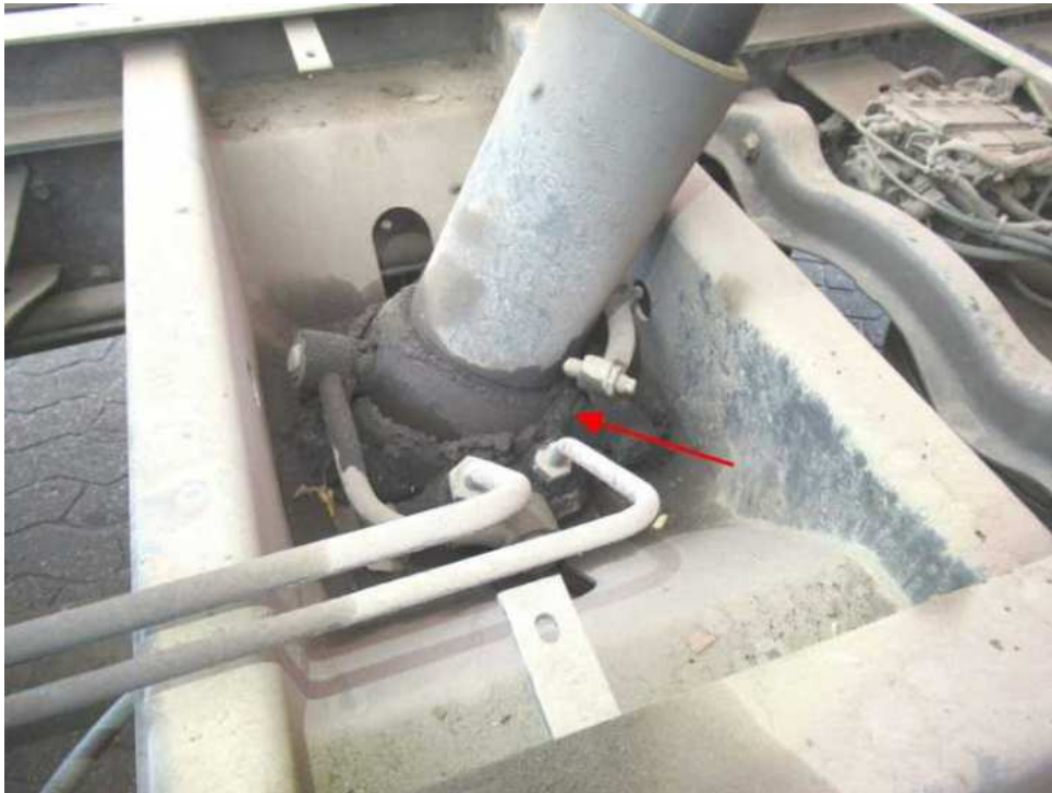
Bild 13 : Kipphydraulikanlage ölundicht reinigen und
