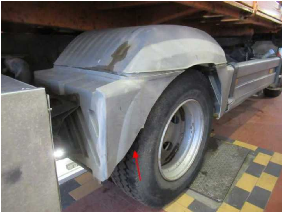
Bild 32 : Kotflügel hinten rechts hinten gebrochen
