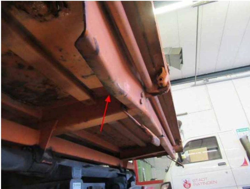
Bild 34 : Verstärkungsblech hinten am Ladeboden verformt
