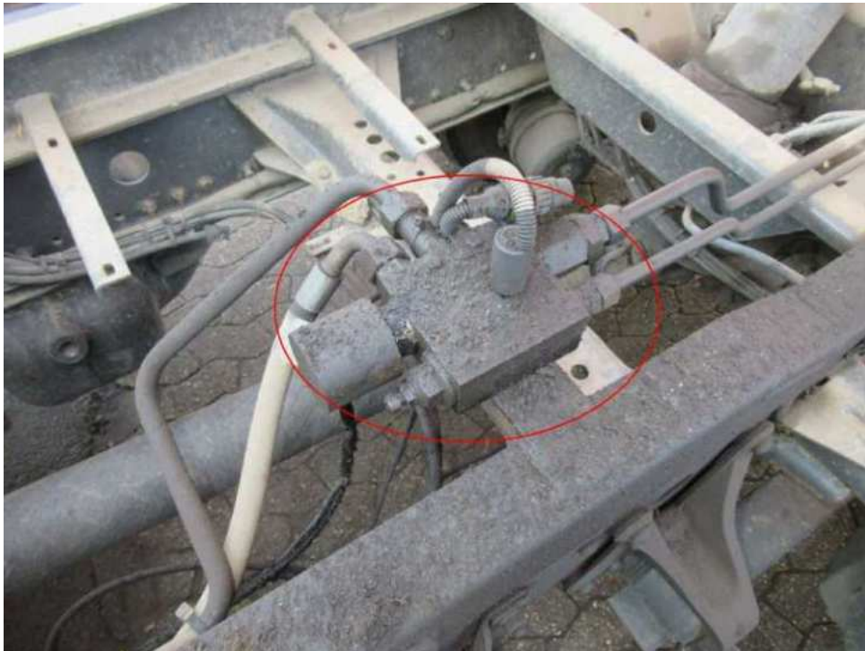
Bild 11 : Kipphydraulikanlage ölundicht reinigen und prüfen
