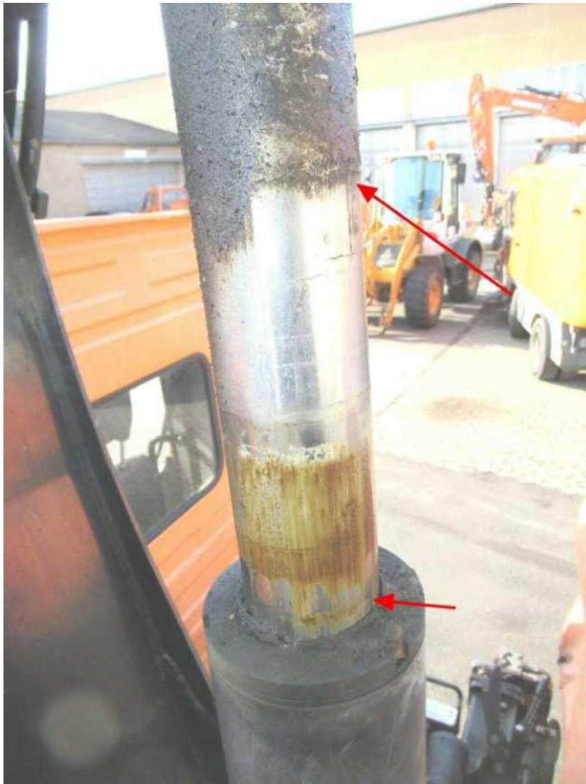
Bild 28 : Hauptzylinder Ladekran undicht, Dichtung prüfen und erneuern
