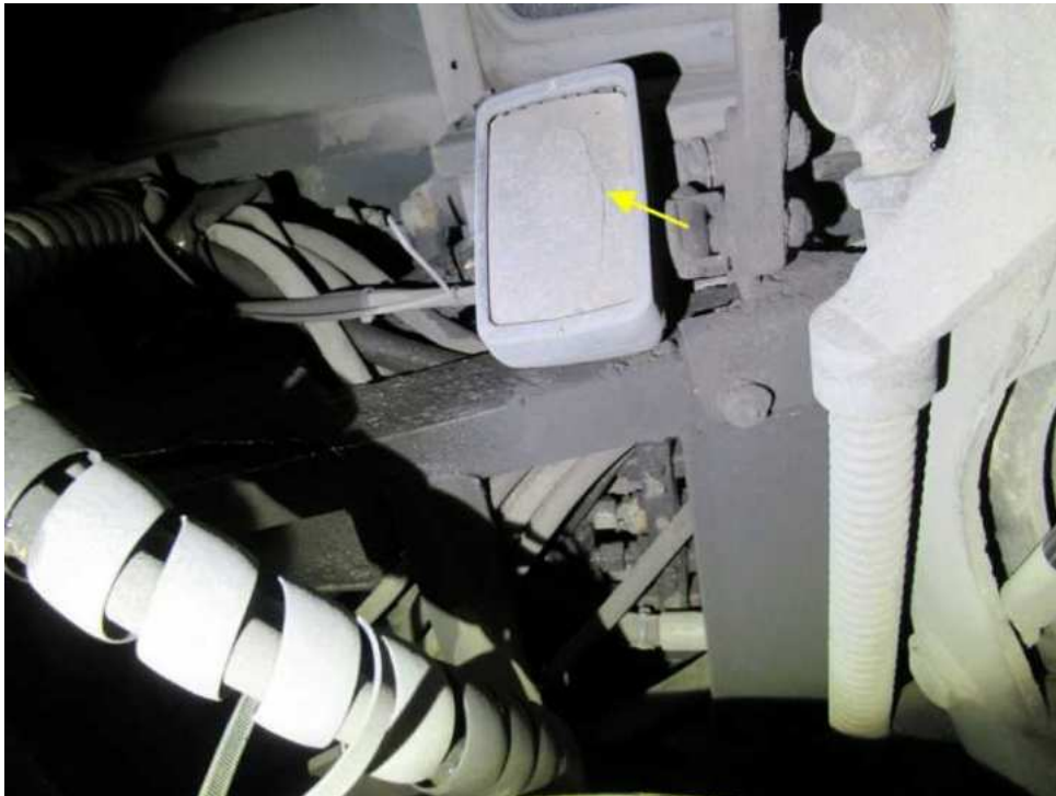
Bild 17 : Arbeitsscheinwerfer Kehrbesen gebrochen
