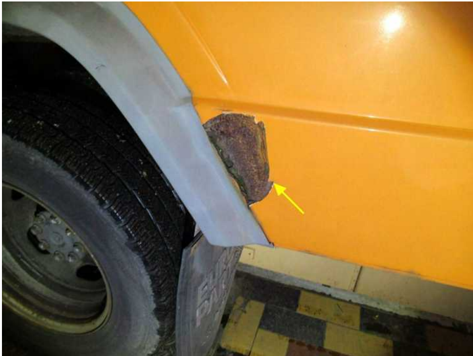
Bild 23 : Radläufe der hinteren Seitenwände starker Rostbefall
