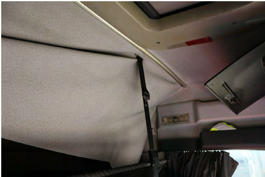
Bild 6 : Dachhimmel löst sich ab
